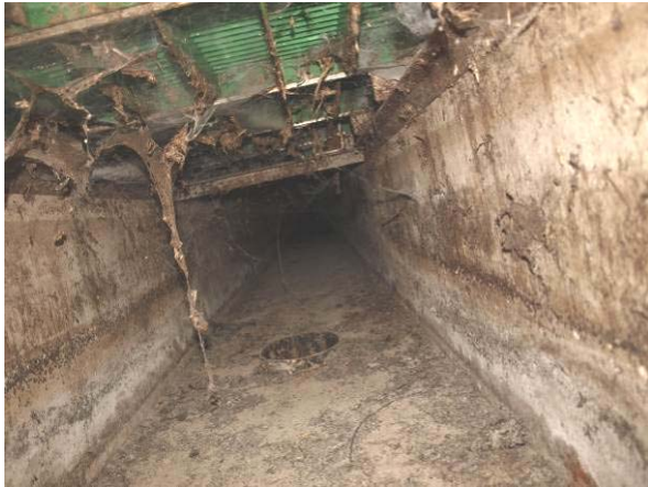
Lüftungschächte am Gebäude 16 ohne Befund (2014, 2015)
