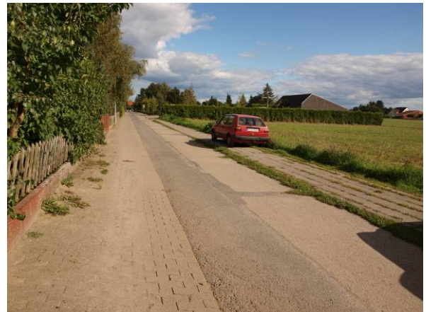
Pastor-Simon-Weg versiegelt bis zum Ende des Grundschulgrundstücks (09/2015)
