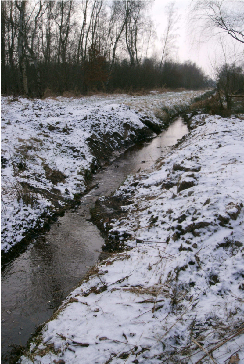
Bilder nach der Beseitigung des Überganges (mit Verrohrung) über den Nordbach (Höhe Druckstation-Klärwerk) in Verlängerung des Weges "Hegebusch"
