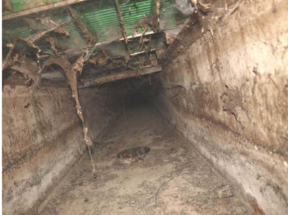
Lüftungschächte am Gebäude 16 ohne Befund (2014, 2015)
