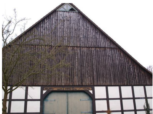
Dachgiebel auch von innen untersucht - Gebäude 5 Alter Gutshof - ohne Befund (Februar 2014)
