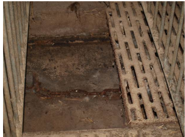
Gülleroste und -kanäle der Ställe im Alten Werkhof ohne Befunde (Februar 2014, März 2015)
