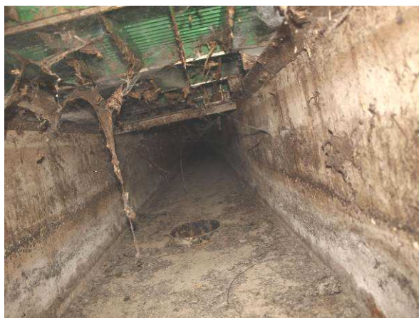
Lüftungschächte am Gebäude 16 ohne Befund (2014),
