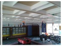
Die PVC Bodenbeläge in 2 Klassenräumen und dem Hortraum sind neu verlegt, in 2 weiteren liegen noch alte PVC Bodenfliesen mit geringer Restlebensdauer. In den Flurbereichen ist robuster Werkstein verlegt. Die Oberfläche ist durch die Abnutzung aufgeraut. Die dunkle Farbgebung erfordert eine leistungsstarke Beleuchtung. Direkter Sanierungsbedarf besteht hier lediglich in der Kontrolle und Nacharbeit der Verfugung. Der Lehrertrakt hat bereits neue Beläge und die WCs neue Fliesen.
