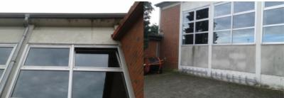
Die Dacheindeckung des Klassentraktes ist neu, der Hort-, Lehrer- und WC-Trakt muss in den nächsten Jahren neu eingedeckt werden, der Betonstein ist relativ verwittert (Links). Die Tonsteineindeckung des Umkleidetraktes zeigt ebenfalls deutl. Verwitterungsspuren (Mitte). Das Sporthallendach muss saniert werden, hier wurde auch die Sanierungsbahn bereits mehrfach geflickt (Rechts)
