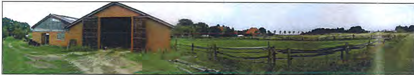
Bild 2: Rinderstall des Landwirtes Langhorst aus nord-östlicher Richtung (Schützenweg)
