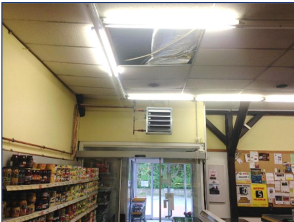
Der Dorfladen in Brelingen vor der Sanierung , Foto: B. Arazin
