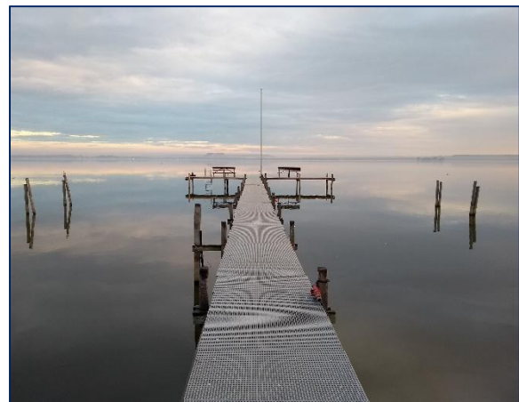
Der neue Steg des Segel-Club Mardorf e.V., Foto: I. Thiele
