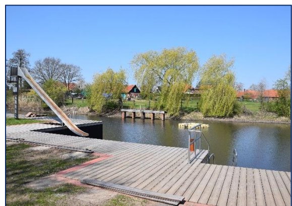
Neuanlage Spundwand Franzseebad in Mandelsloh, Foto: SWECO GmbH
