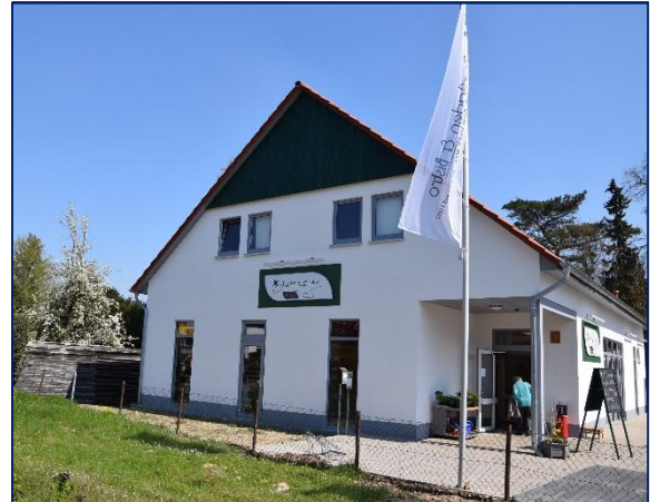
Der neu errichtete Dorfladen Mariensee, Foto: SWECO GmbH
