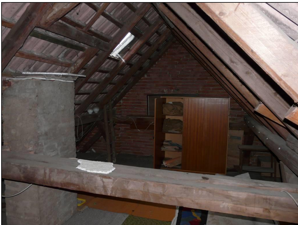
Dachboden des leer stehenden Wohngebäudes
