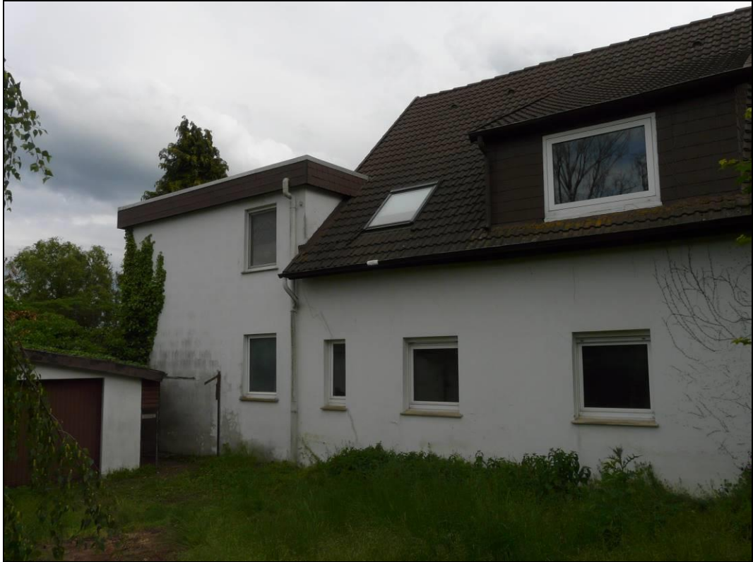
Leer stehendes Wohngebäude mit Nebengebäude (Nordansicht)
