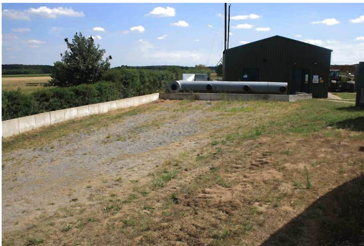
Abbildung 2-1: Zur Errichtung des BHKW vorgesehene Fläche.
