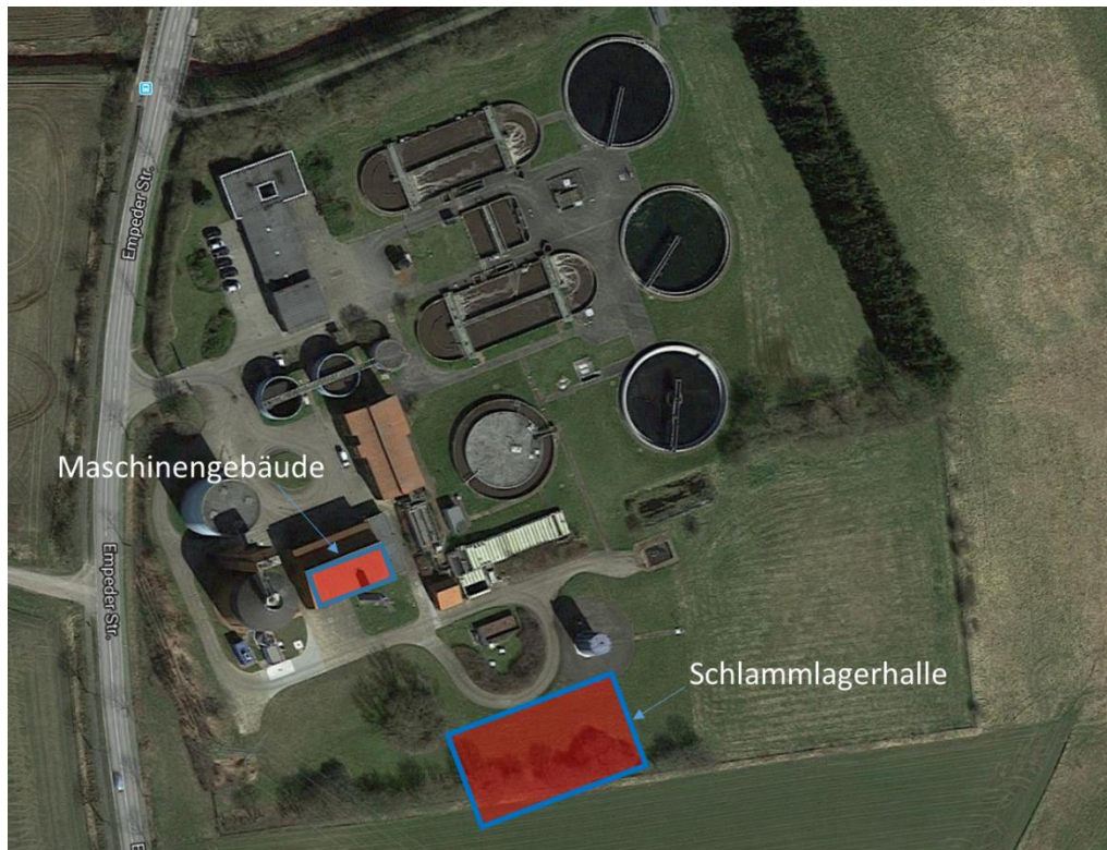
Abbildung 1: Potentielle Dachflächen der Kläranlage Empede
