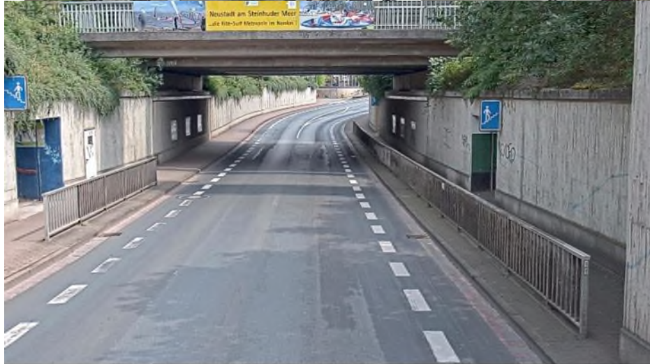
Straße: K347, Abschnitt: 10 | 35210250 - 34220040, Station: 11174, Lage: R, FS: 1
