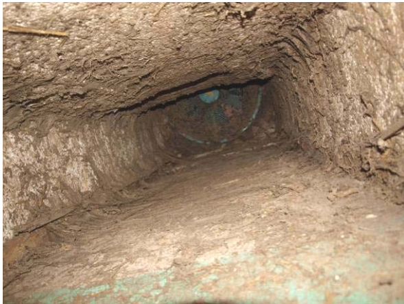
Schornsteine ohne Befund in den Geb. 14, 15 und 16 im Alten Werkhof (2014, 2015)
