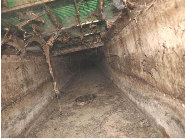
Lüftungschächte am Gebäude 16 ohne Befund (2014, 2015)
