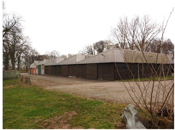
Maschinenhalle und Betriebsflächen im zentralen Bereich (Blick nach Norden)
