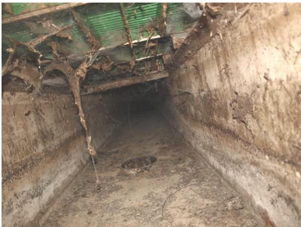
Lüftungschächte am Gebäude 16 ohne Befund (2014, 2015)
