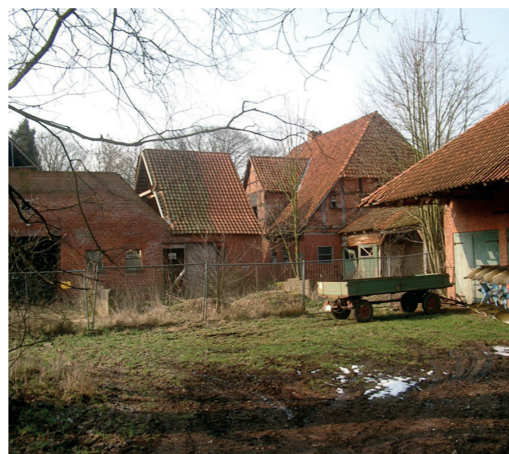
Hofgebäude kurz vor dem Abriss; 2007.
