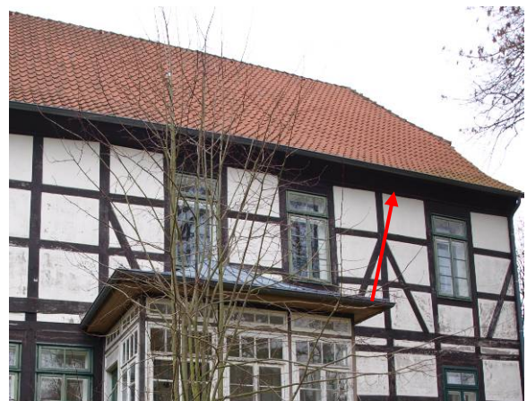
Gebäude 33 Südostseite im Alten Gutshof, Anbringung 3er-Nistkasten für Haussperling
