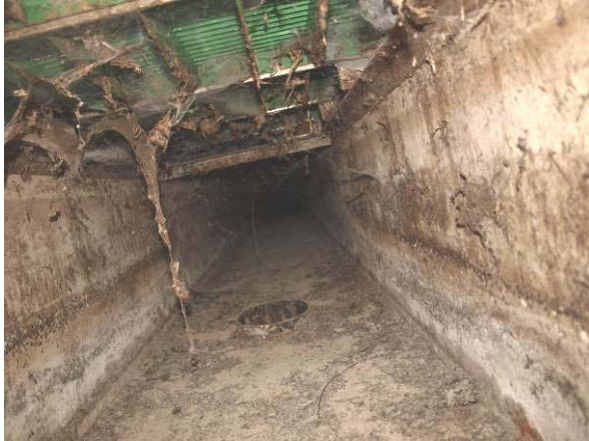
Lüftungschächte am Gebäude 16 ohne Befund (2014, 2015)
