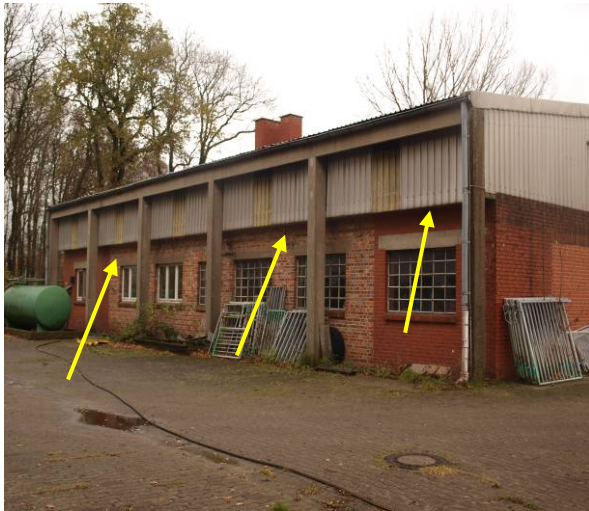
Gebäude 3.1 Nordostseite im Alten Gutshof, Anbringung von 6 Doppel-Betonschalen
