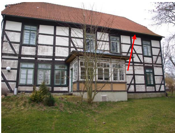
Gebäude 33 Südostseite im Alten Gutshof, Anbringung 3er-Nistkasten für Haussperling
