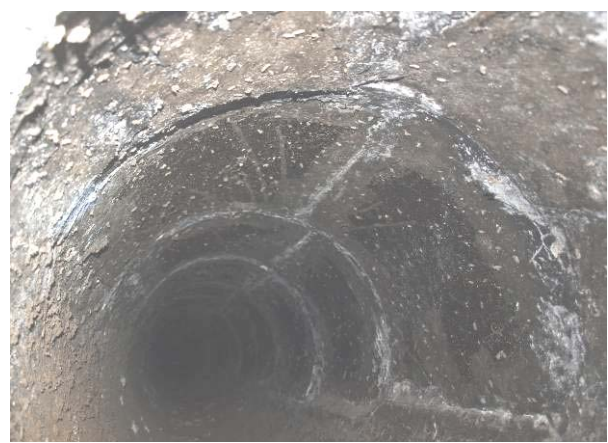
Geöffnetes Lüftungsrohr im Dachboden Gebäude 5 Alter Gutshof - ohne Befund (Februar 2014)
