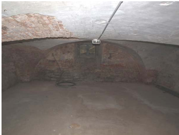
Gewölbekeller hermetisch abgeschlossen - Geb. 33 im Alten Gutshof - ohne Befund (Februar 2014)
