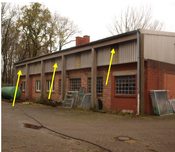
Gebäude 3.1 Nordostseite im Alten Gutshof - Anbringung von 6 Fledermauskästen
