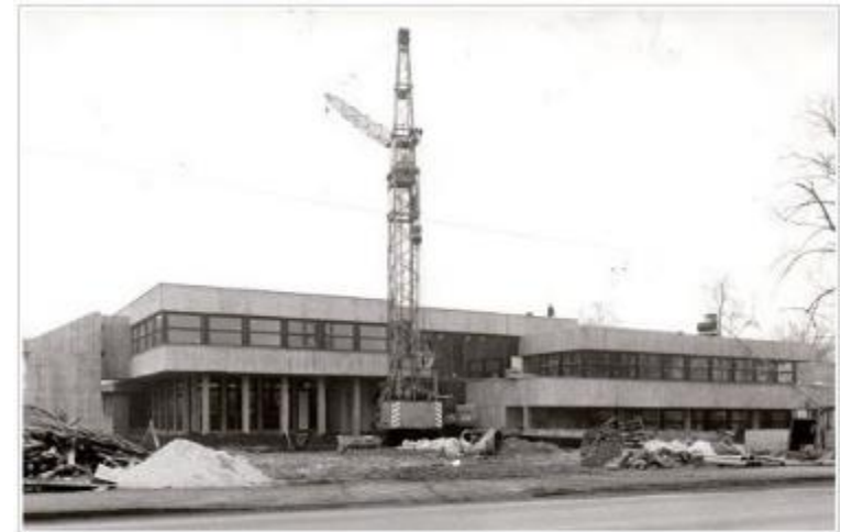
Das Neustädter Freizeitzentrum im Bau (Foto: Moldenhauer)
