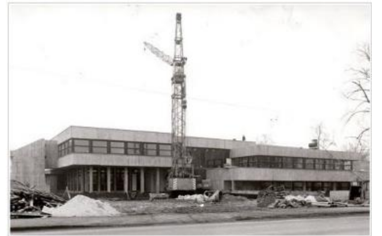
Das Neustädter Freizeitzentrum im Bau (Foto: Moldenhauer)
