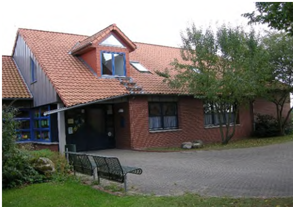
Anbau von 1991 mit 3 Klassenräumen Verwaltungsräumen, Werkraum und WC's
