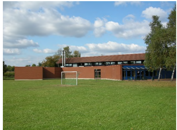
Ansicht Turnhalle, Baujahr 1980 (noch ohne Mensa)
