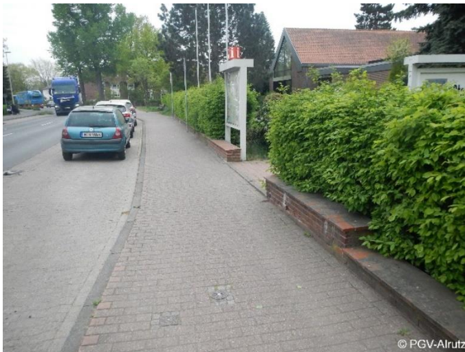
Nienburger Straße Gemeinsame Führung Fuß- und Radverkehr, z.T. im Zweirichtungsverkehr in unzureichender Breite, fehlender Sicherheitstrennstreifen
