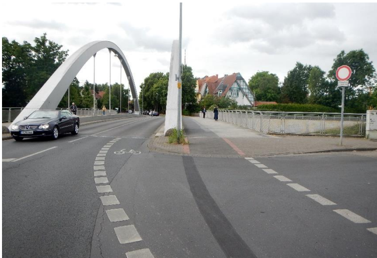
Abb. 5-8: Überleitung auf Fahrbahn (duale Führung) oder den nicht benutzungspflichtigen baulichen Radweg (Hannover)
