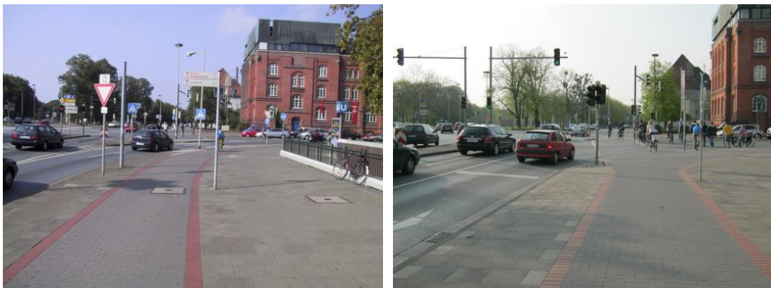
Abb. 5-20: Rückbau und Signalisierung eines konfliktträchtigen freien Rechtsabbiegefahrstreifens in Hannover (links vorher, rechts nachher)
