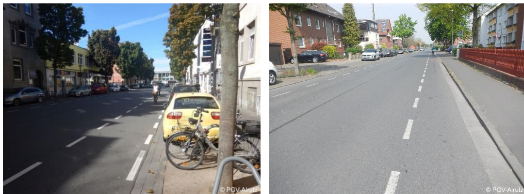
Abb. 5-11: Links: Schutzstreifen mit Sicherheitstrennstreifen zu parkenden Kfz (Hildesheim); rechts: beidseitiger Schutzstreifen (Neustadt a. Rbge., Königsberger Straße)
