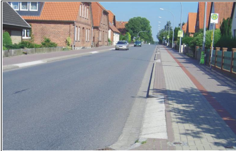
Abb. 5-3: Grundstückszufahrten mit Rampenstein (Soltau)
