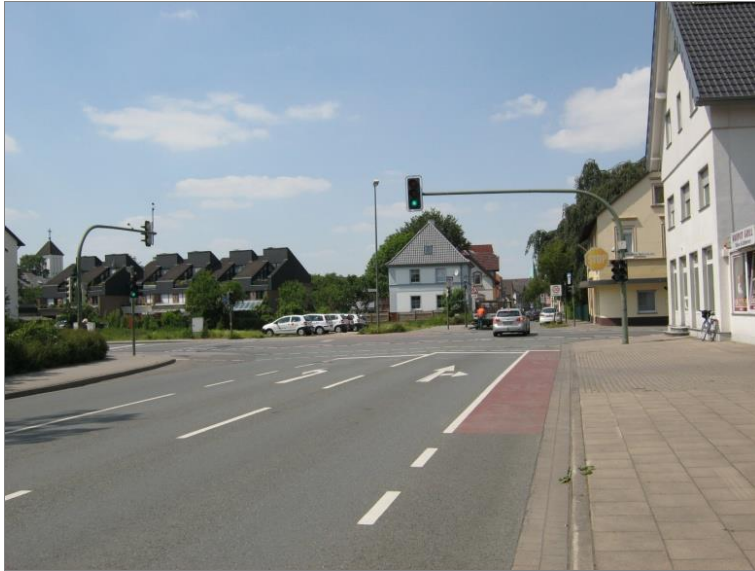
Abb. 5-19: Vorbeifahrtstreifen in einer signalisierten Knotenpunktzufahrt (Bielefeld)
