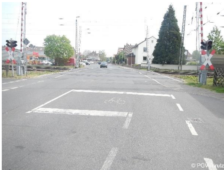
Abb. 5-21: Aufgeweiteter Radaufstellstreifen (ARAS) (Neustadt a. Rbge., Siemensstraße)
