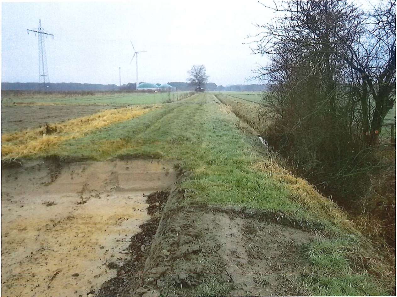
Bild 2: Derzeitiger Zustand Weg 4 (Blick nach Osten)
