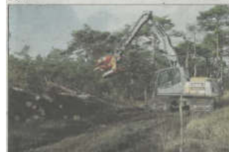
Schweres Gerät ist im Einsatz.
