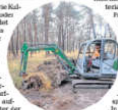
Ein Landschaftsbauer verzichtet mit dem Kleinbagger Entwässerungsgräben.
