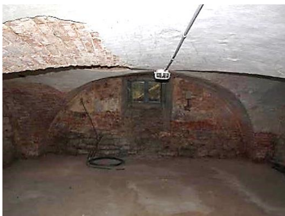
Alter Gutshof, Gebäude 33: Gewölbekeller hermetisch abgeschlossen - ohne Befund (April 2021)
