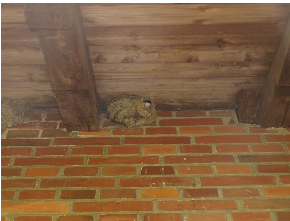
Alter Gutshof – Gebäude 5: ca. 5 Mehlschwalbenbruten im Jahr 2021
