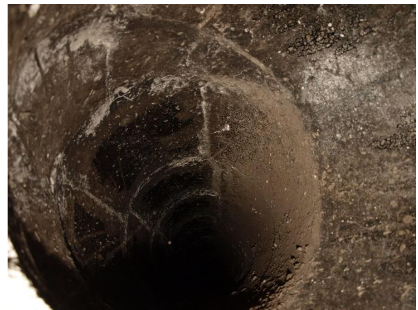
Alter Gutshof, Gebäude 5: Geöffnetes Lüftungsrohr im Dachboden - ohne Befund (April 2021)
