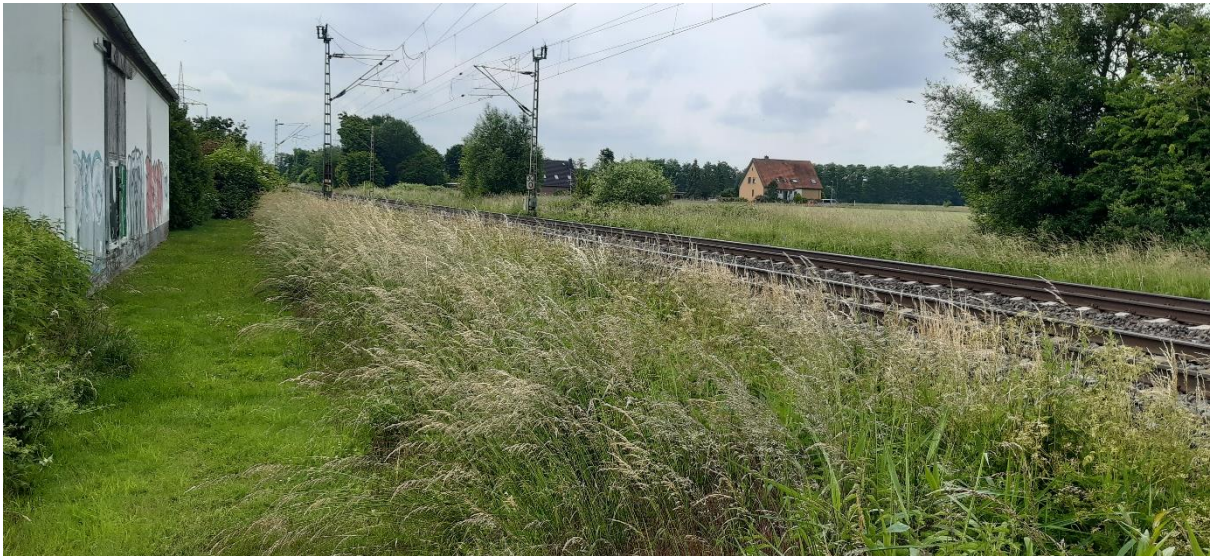
Abbildung 6 Ort der geplanten Straßenüberführung (eigene Aufnahme)
