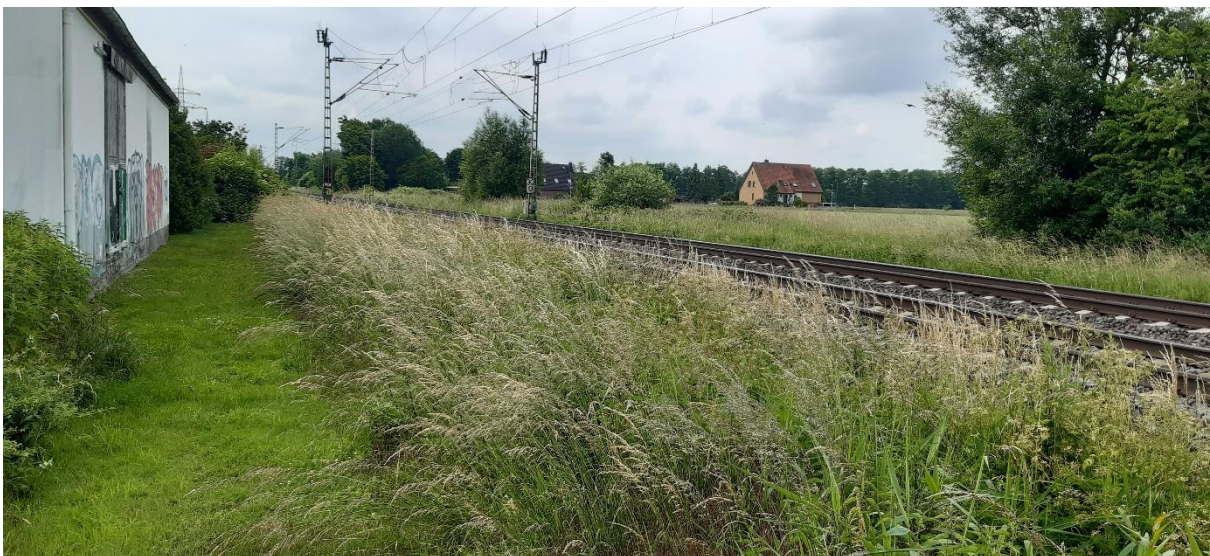
Abbildung 10 Ort der geplanten Straßenüberführung (eigene Aufnahme)
