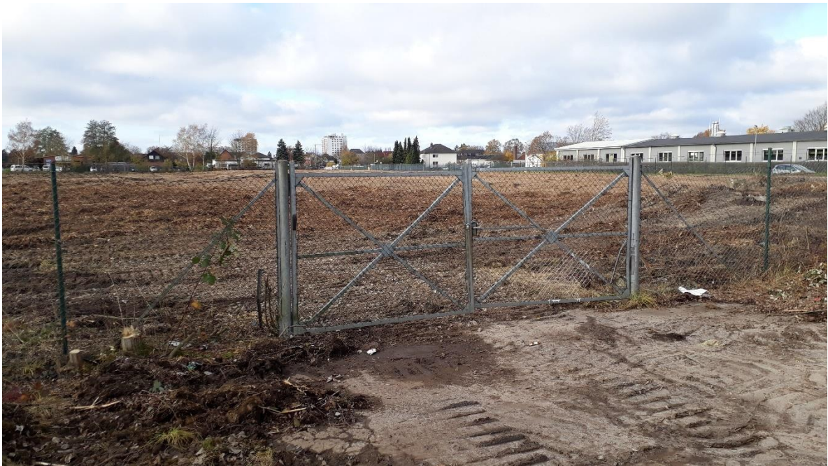
Abbildung 2-7: Im Nordwesten des Untersuchungsgebietes wurden nach Ende der Erfassung Gehölze gerodet und der Oberboden planiert (12.11.2021)
