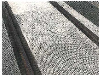
Bild: Spurrillensicherung Am Dänenberg
