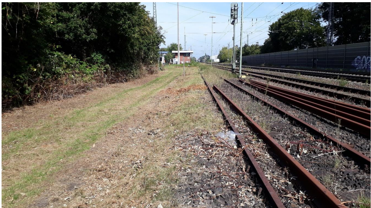
Abbildung 2-2: Blick längs der Bahn Richtung Nord; im Hintergrund der Bahnübergang Siemensstraße (06.09.2021)
