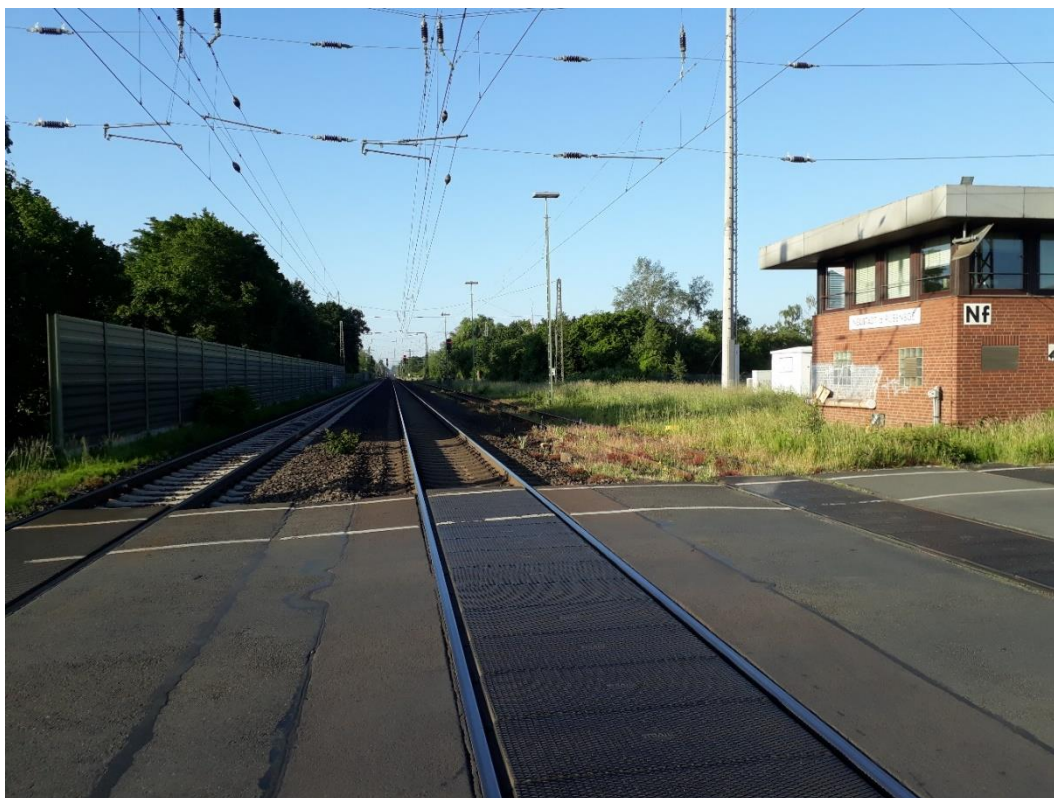
Abbildung 4-2: Bahnübergang Siemensstraße und Blick längs der Bahnstrecke nach Süden (10.06.2022)
