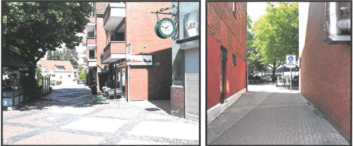
Abb. 2 + 4: Die schlechten Sichtverhältnisse erfordern weitere Maßnahmen
