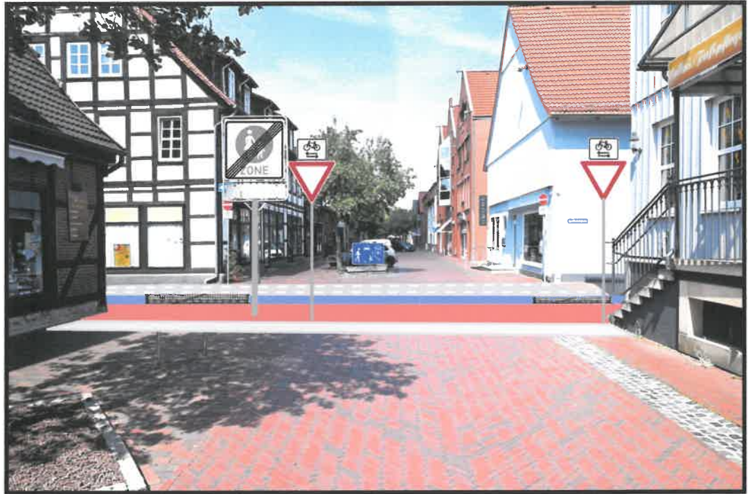
Abb. 17: Ende der Fg-Zone und Anfang des verkehrsberuhigten Bereiches prüfen
