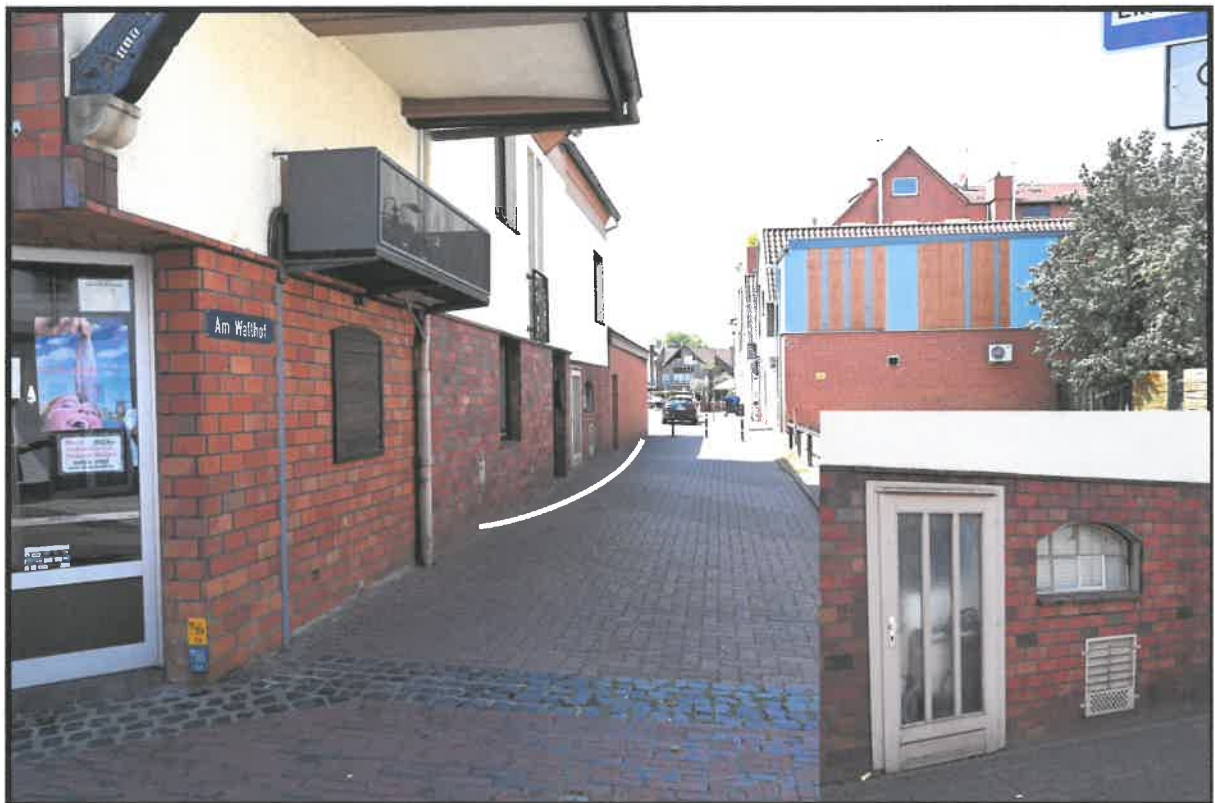
Abb. 7: Prüfen, ob eine Markierung zur Sicherung der Tür erforderlich ist
