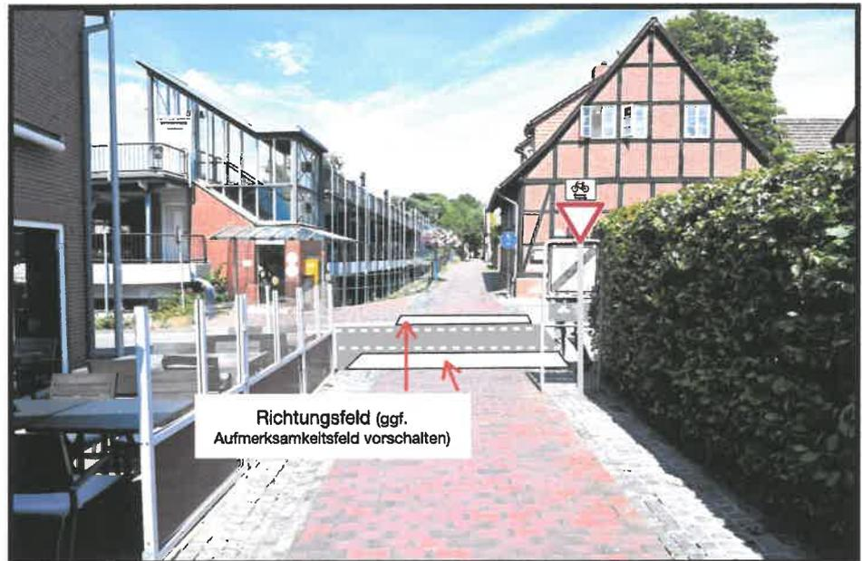
Abb. 11 + 12 (unten): Querungsstelle mit Vorrang für die Fahrradstraße. Für sehbehinderte und blinde Verkehrsteilnehmer wird zur Orientierung ein Richtungsfeld und ggf. ein Aufmerksamkeitsfeld am Fahrbahnrand der Fahrradstraße eingefügt.
