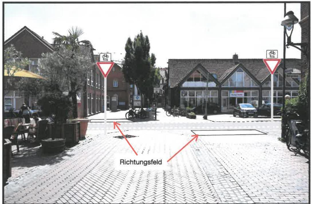
Abb. 13 + 14 (unten): Querungsstelle mit Vorrang für die Fahrradstraße. Richtungsfeld und ggf. Aufmerksamkeitsfeld einplanen.
