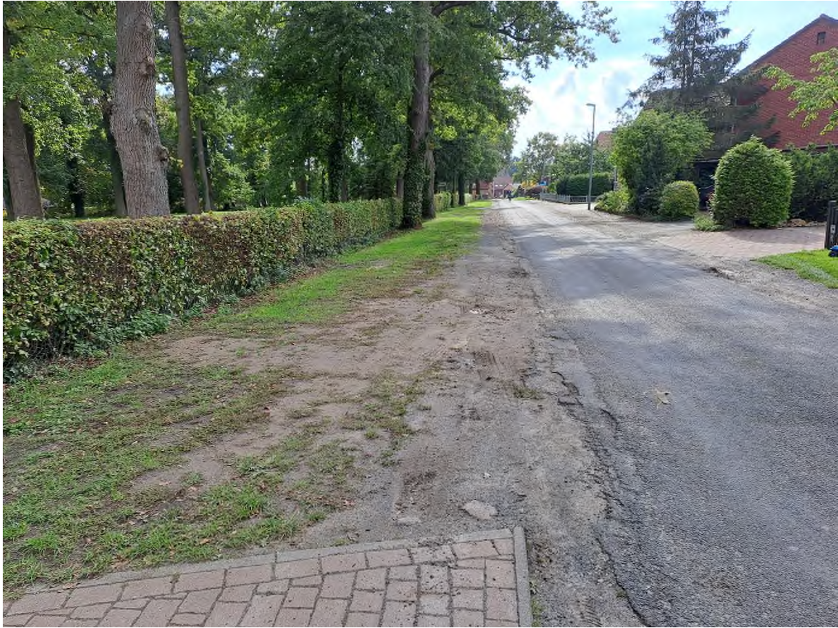
Straße „Vor der Mühle“, Stadtteil Mardorf
