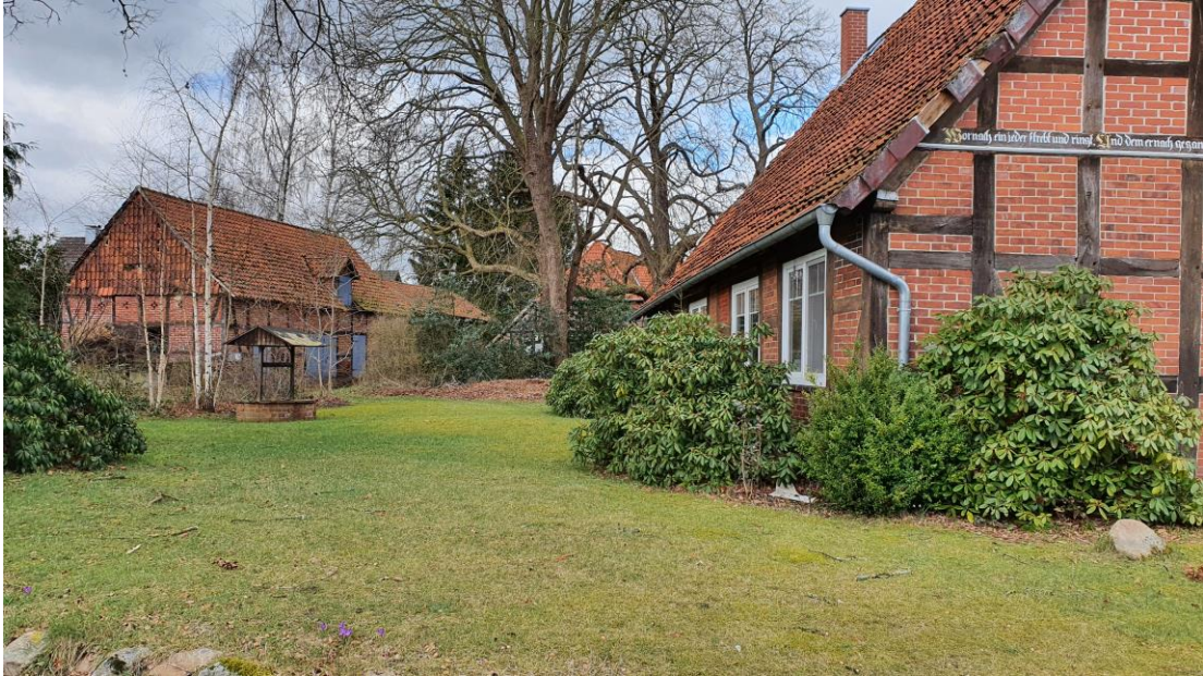
Abb. 13: Nebengebäude Bornwiesen 7 und Wohnhaus Bornwiesen 9
