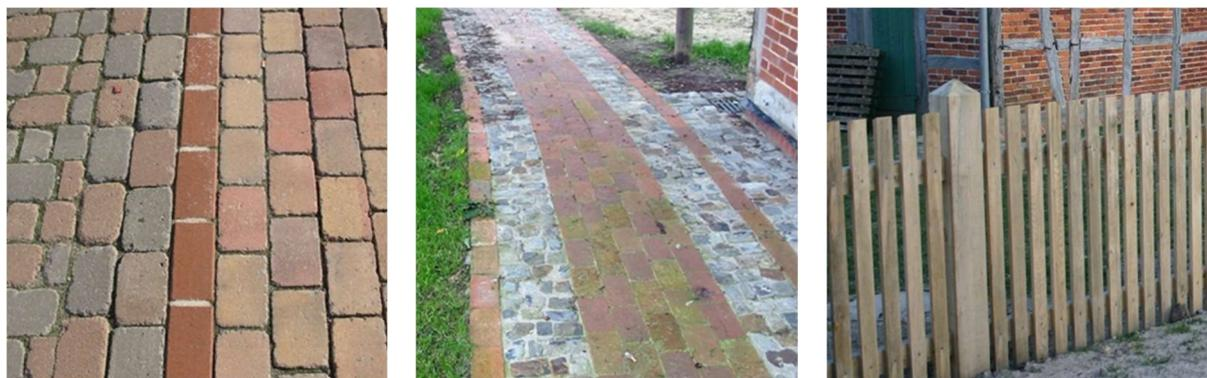
Abb. 98 Beispiele: gerumpeltes Betonrechteckpflaster, Naturstein/Klinker, Holz-Staketenzaun
