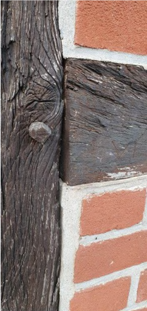
Nordseite – Fugenschäden
