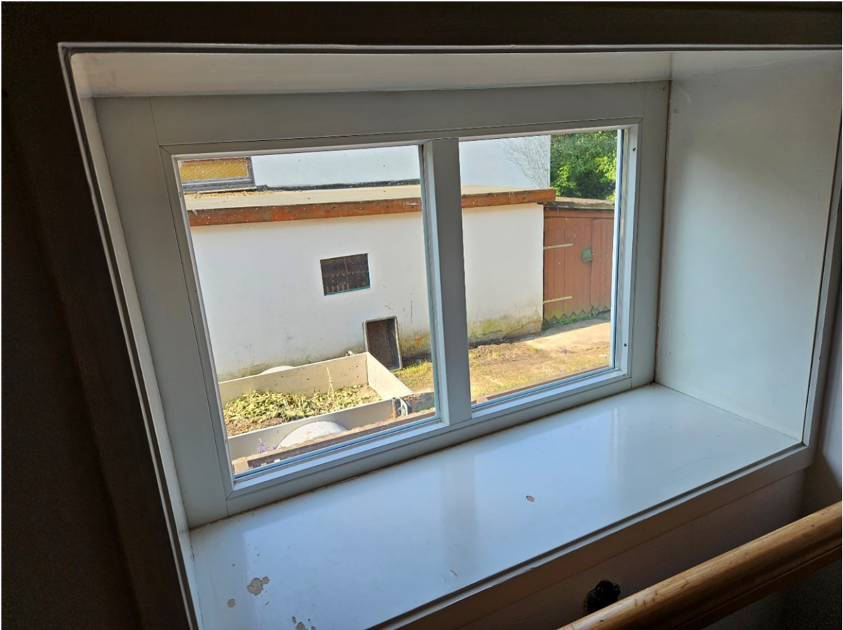
Nordseite – Fenster, innen
