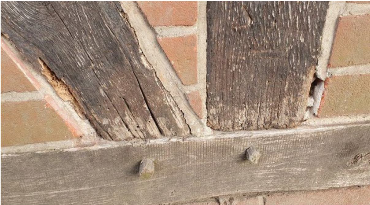
Nordseite – Balken und Fugen
