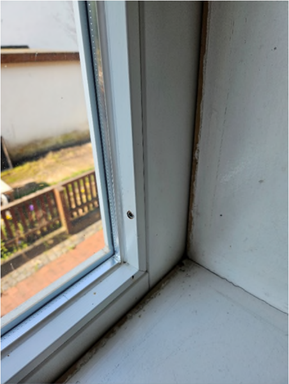
Nordseite – Fenster, innen
