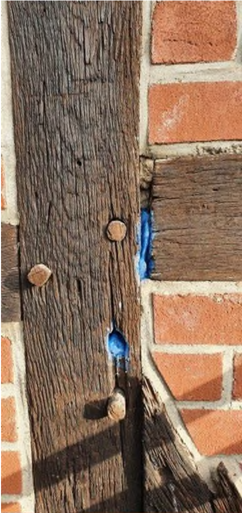
Nordseite – Fugenschäden
