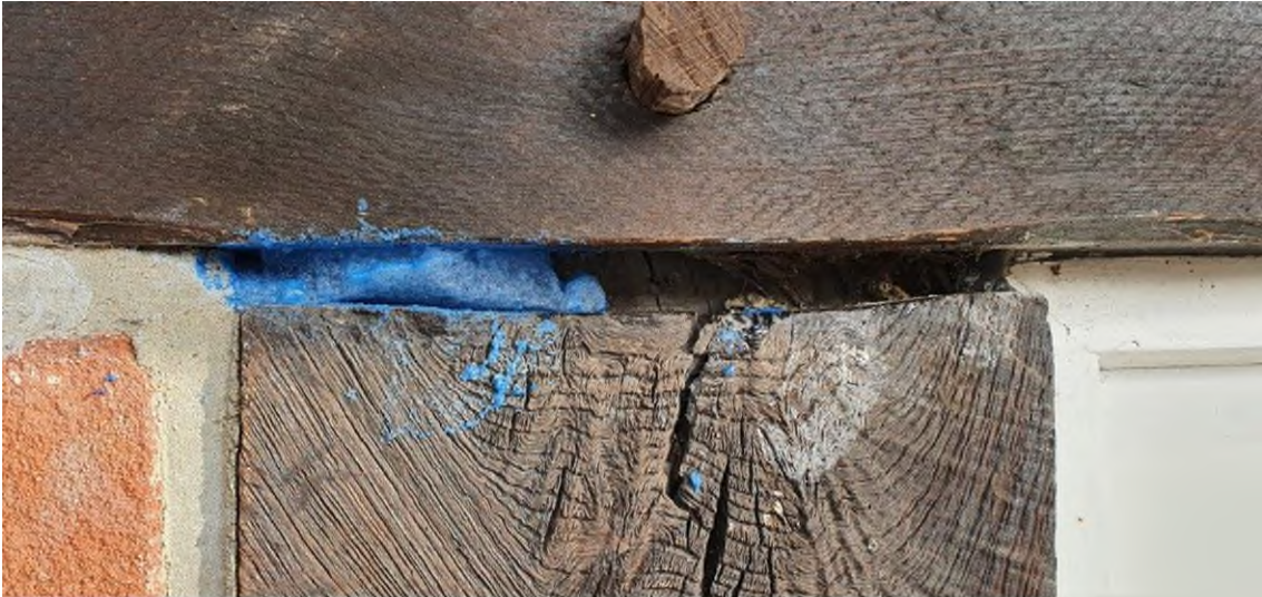
Nordseite - Fugenschäden
