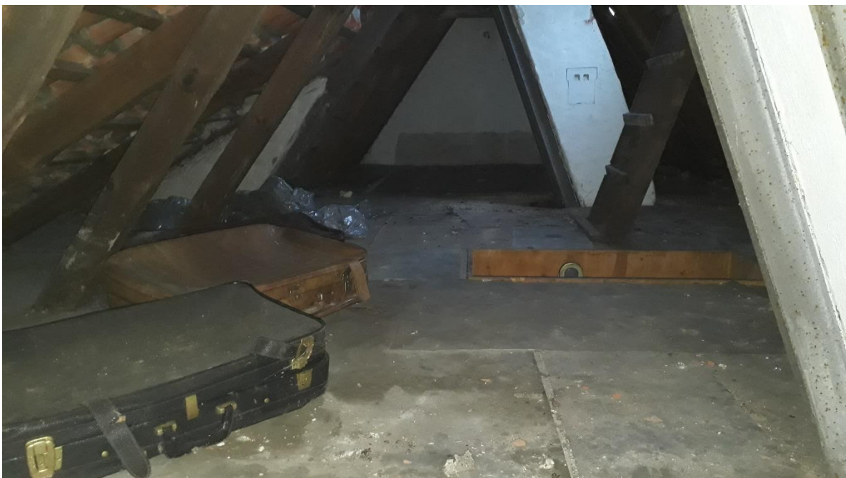
Abbildung 2-6: Der Dachboden des Gebäudes
