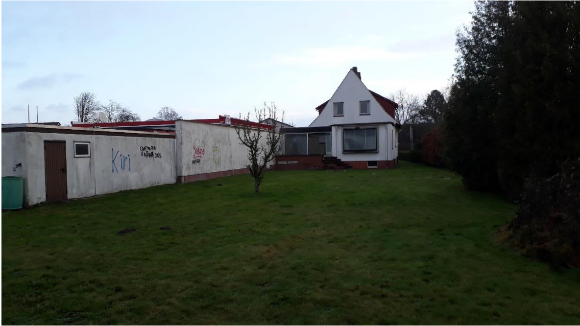
Abbildung 2-5: Das Wohngebäude von der Gartenseite aus gesehen
