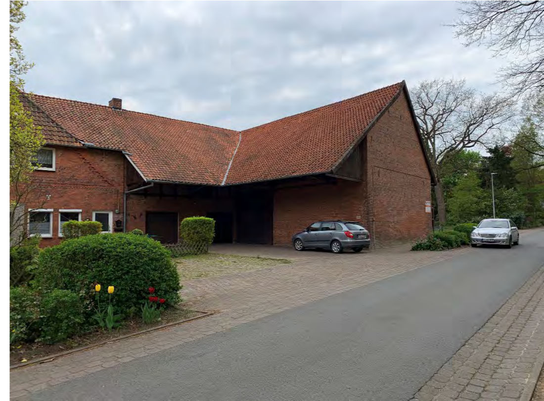
Südlicher Nachbar am „Alter Sandberg“
