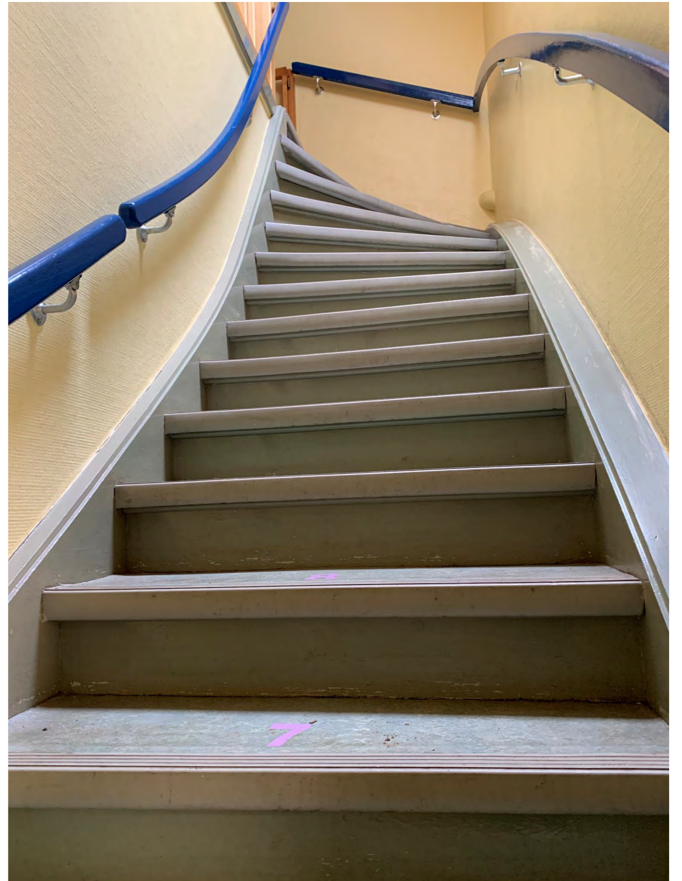
Gewendelte Treppe ins Obergeschoss
