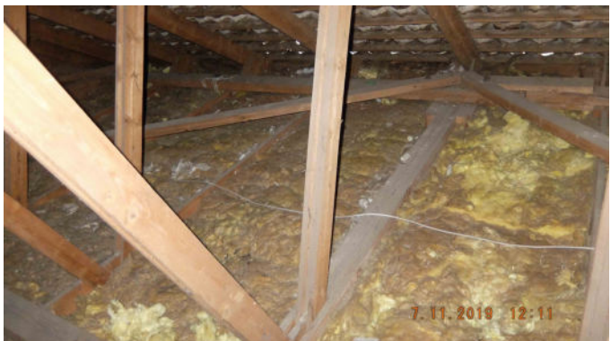
Dämmung oberste Geschosdecke
