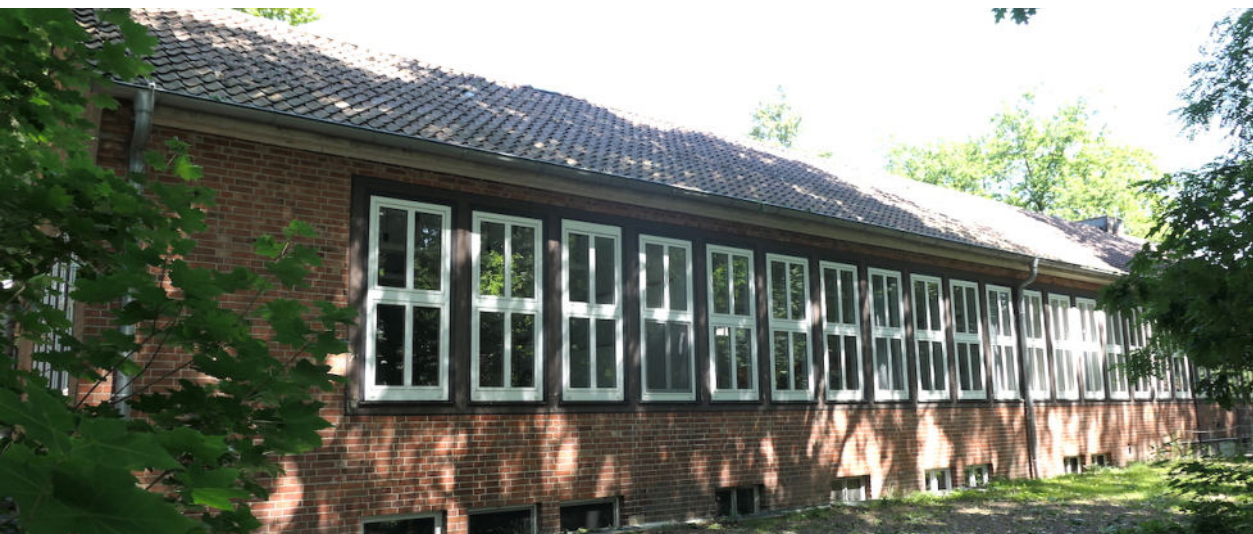
Südensicht Hauptgebäude A - Fenster der Klassenräume
