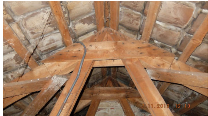
Dachboden im Gebäudeteil A mit Wartungssteg über Klassenräumen - Firstkonstruktion
