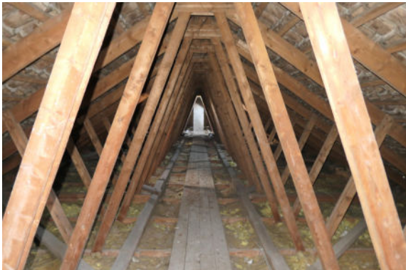
Dachboden im Gebäudeteil A mit Wartungssteg über Klassenräumen - Firstkonstruktion
