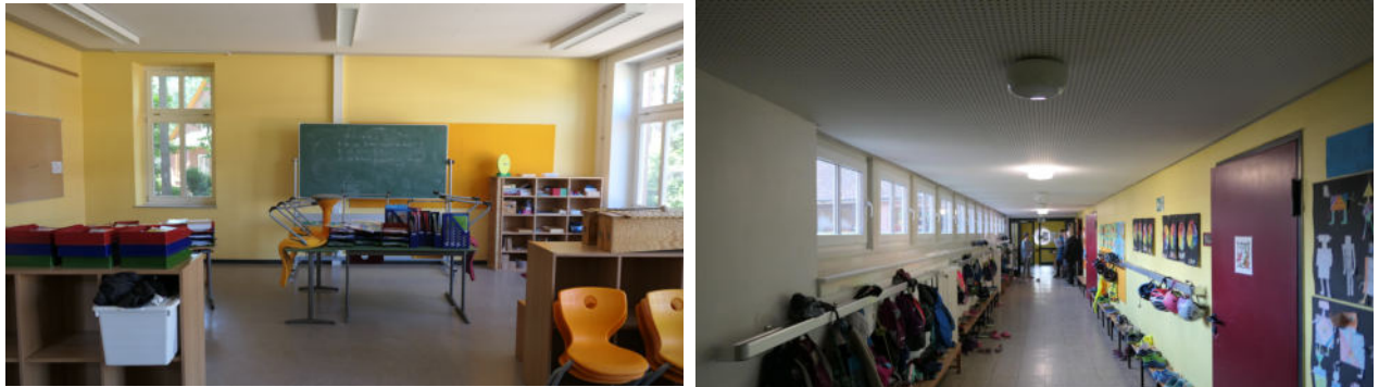
EG: Mehrzweckraum im Anbau von 1997 und Flur mit Garderoben vor den Klassenzimmer
