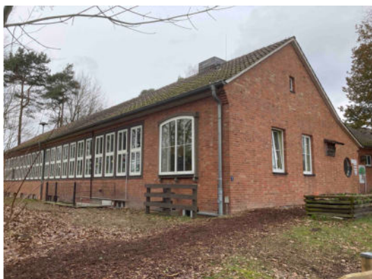
Schulgebäude vom Süd-Osten
