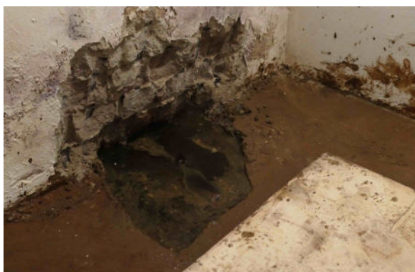
KG: Bereich unter der Treppe
