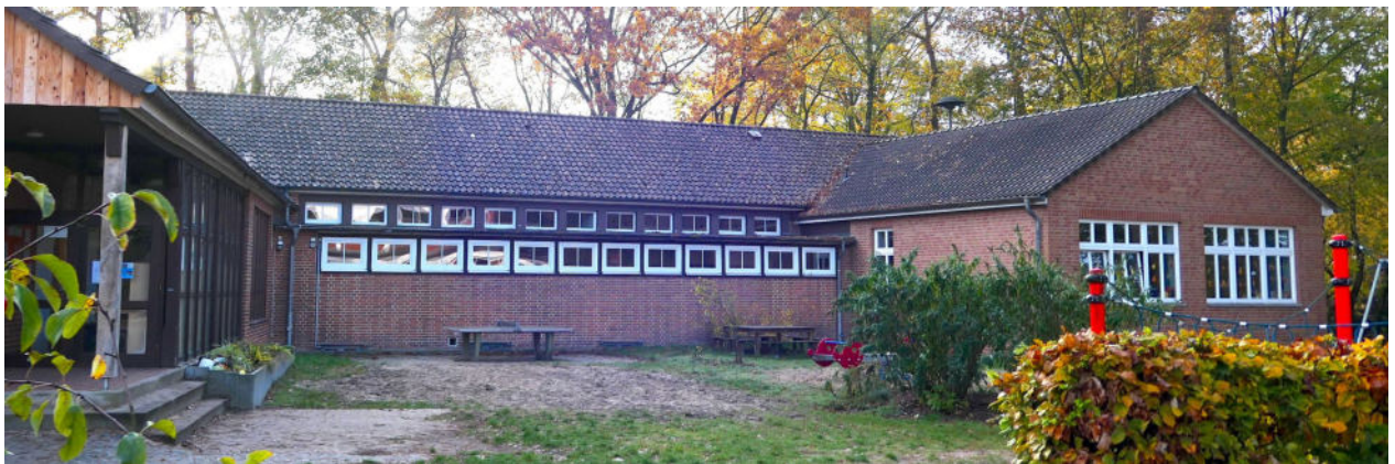
Nordansicht Hauptgebäude A - Blick vom Schulhof
