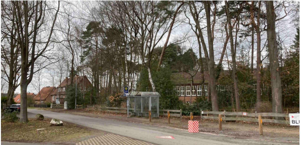
Südansicht Hauptgebäude A - Waldstraße und Bushaltestelle
