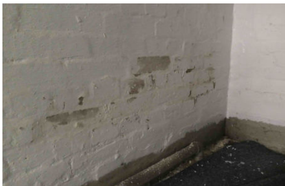
KG: Bereich unter der Treppe
