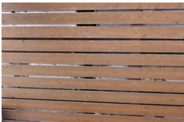
Seitenflügel B: Decke Unterstand + Flur
