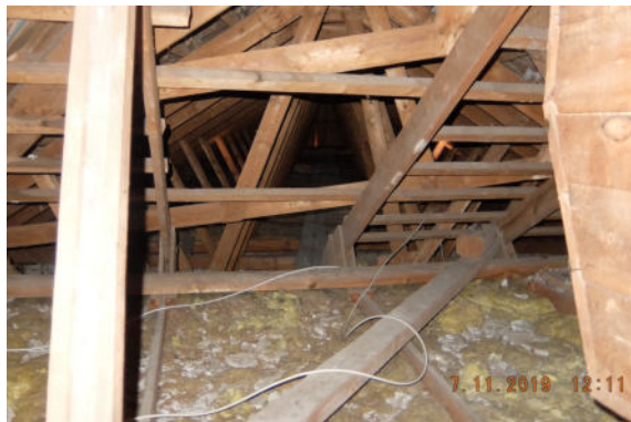
Dachboden über Gebäudeteil B
