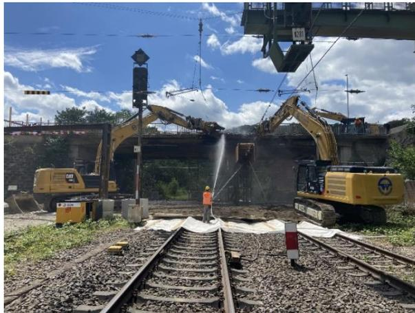
Abbildung 7: Konventioneller Abbruch einer Brücke über Bahnanlagen
