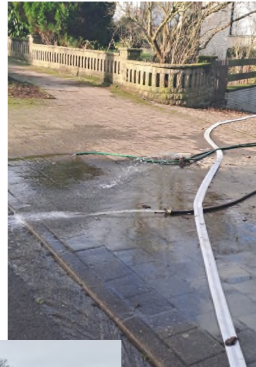
Abgepumpte Keller, oft Einleitung in den SW-Kanal
