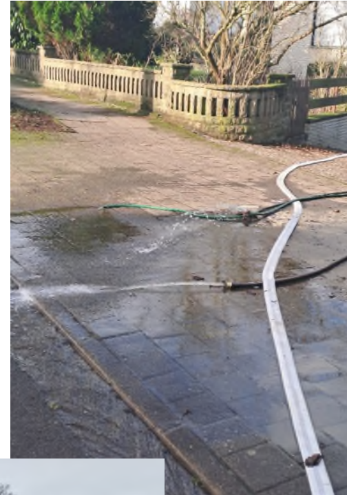
Abgepumpte Keller, oft Einleitung in den SW-Kanal
