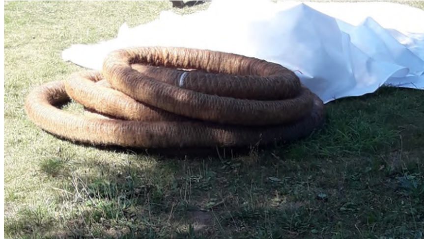
Falsch angeschlossene Drainagen und Fallrohre
