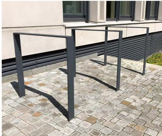
Abb. 99: Flachstahl-Fahrradbügel
