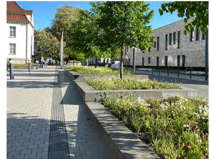
Abb. 172: Taktile Elemente zeigen Wegeverbindungen auf
