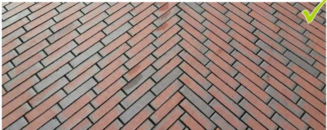
Abb. 32: Diagonal-Verband mit Naht
