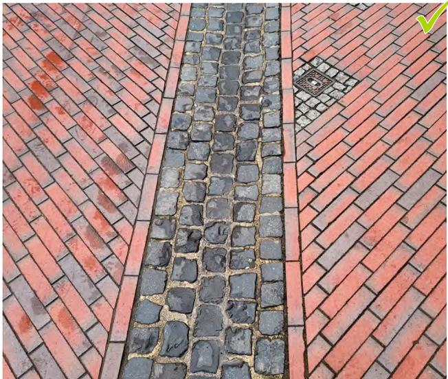
Abb. 31: Bockhorner Klinkerriegel mit Basaltgosse
