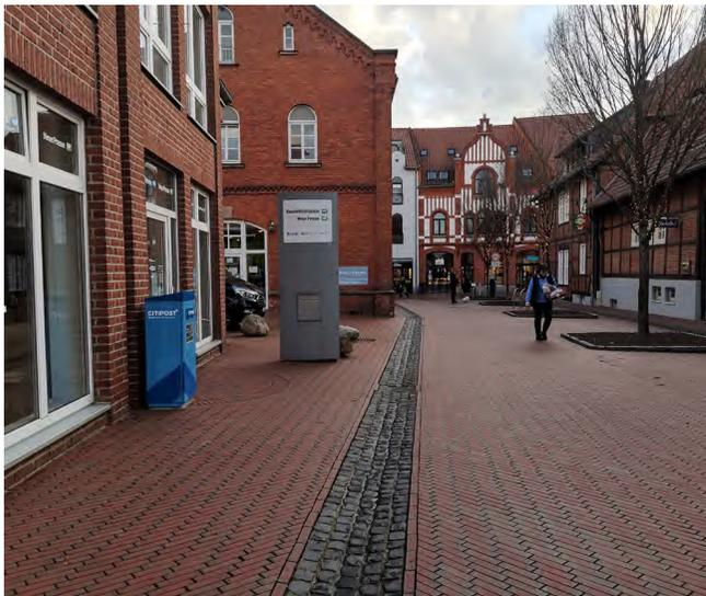
Abb. 173: Fünfreiher Basaltstreifen als Gasse und taktile Leitlinie
