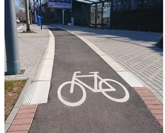
Abb. 159: Asphaltierter Radweg im starken Kontrast zur Umgebung
