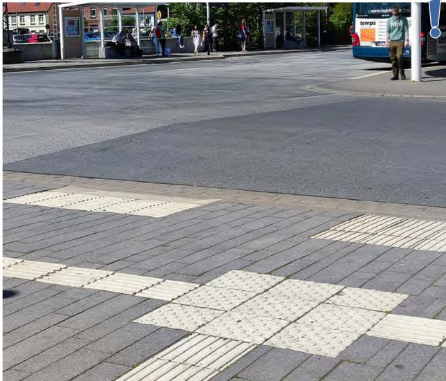
Abb. 9: Weiße Rillenplatten als taktiles Leitsystem
