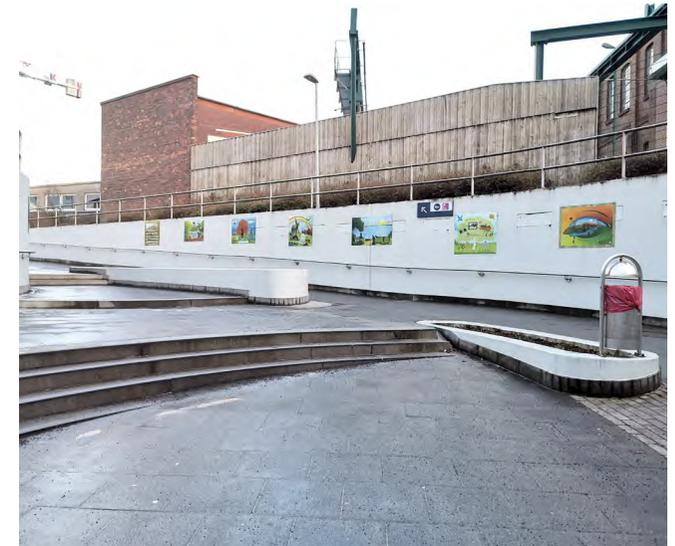
Abb. 171: Integration von Rampen an Stufenanlagen
