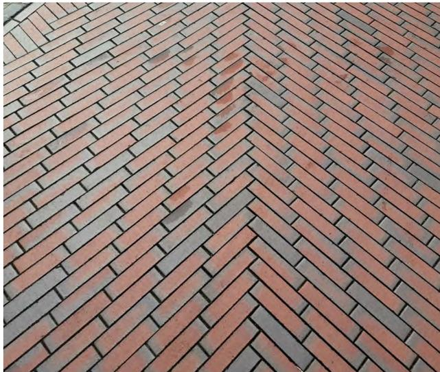
Abb. 151: Orientierung an Verlegeart des Bestandpflasters
