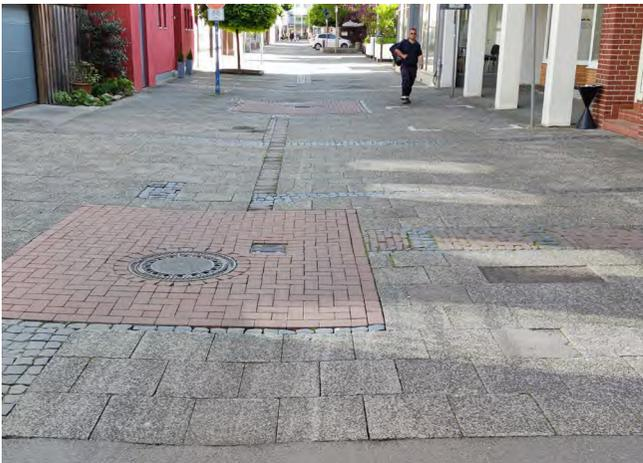
Abb. 84: In den Seitenräumen teilweise starke Ausbesserungen der Ober- fläche mit unterschiedlichen Materialien vorhanden
