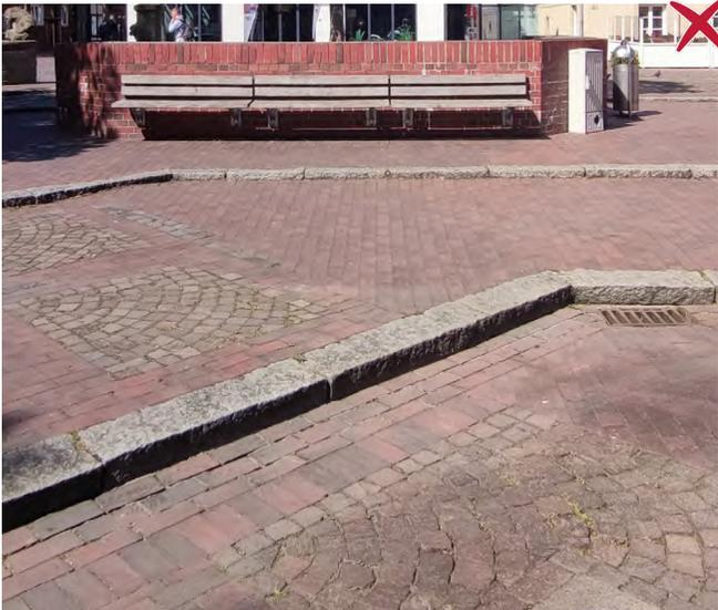
Abb. 54: Klinkerpfaster und Kopfsteinpfaster mit Stufen
