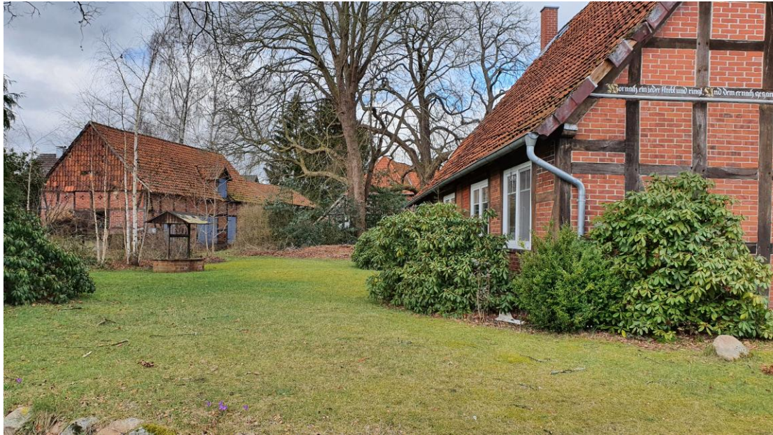
Abb. 13: Nebengebäude Bornwiesen 7 und Wohnhaus Bornwiesen 9
