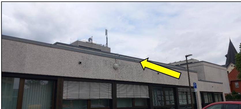
Abbildung 36: Bleche über den Fassadenplatten (gelber Pfeil).
