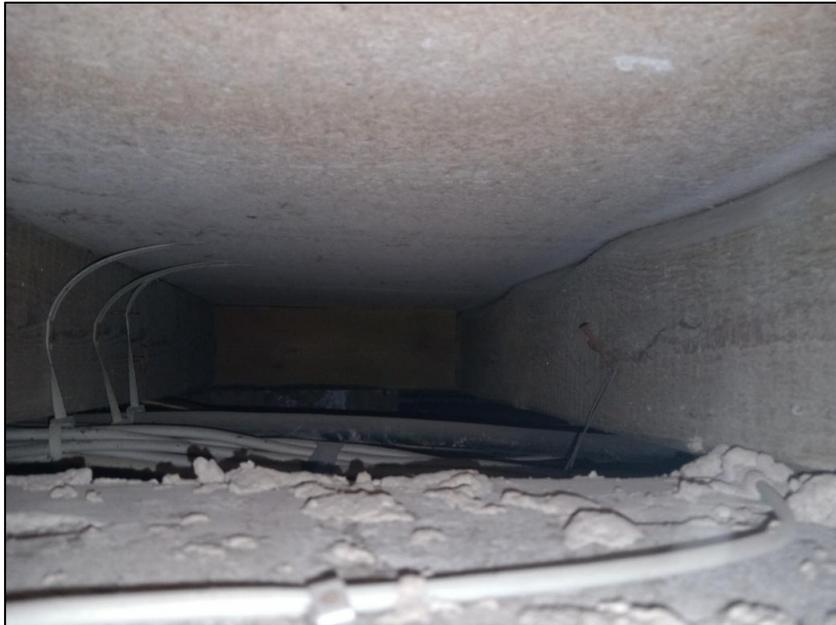
Abbildung 6: Leerer Kabelschacht an der Dachkante (s. Abb. 5).
