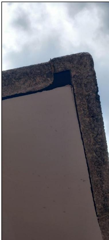
Abbildung 28: Hohlraum zwischen Fassadenplatte und Gebäudewand.
