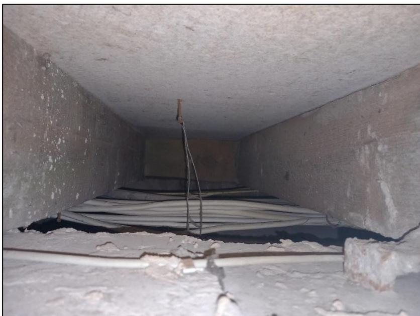
Abbildung 7: Weiterer leerer Kabelschacht an der Dachkante (s. Abb. 5).
