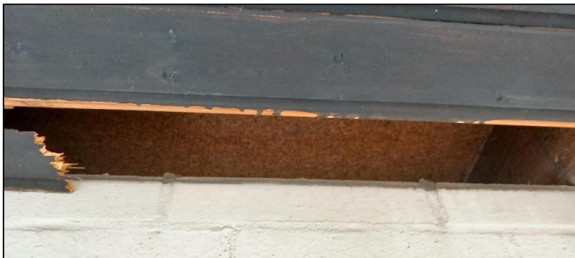
Abbildung 5: Spalte an einer Dachkante.
