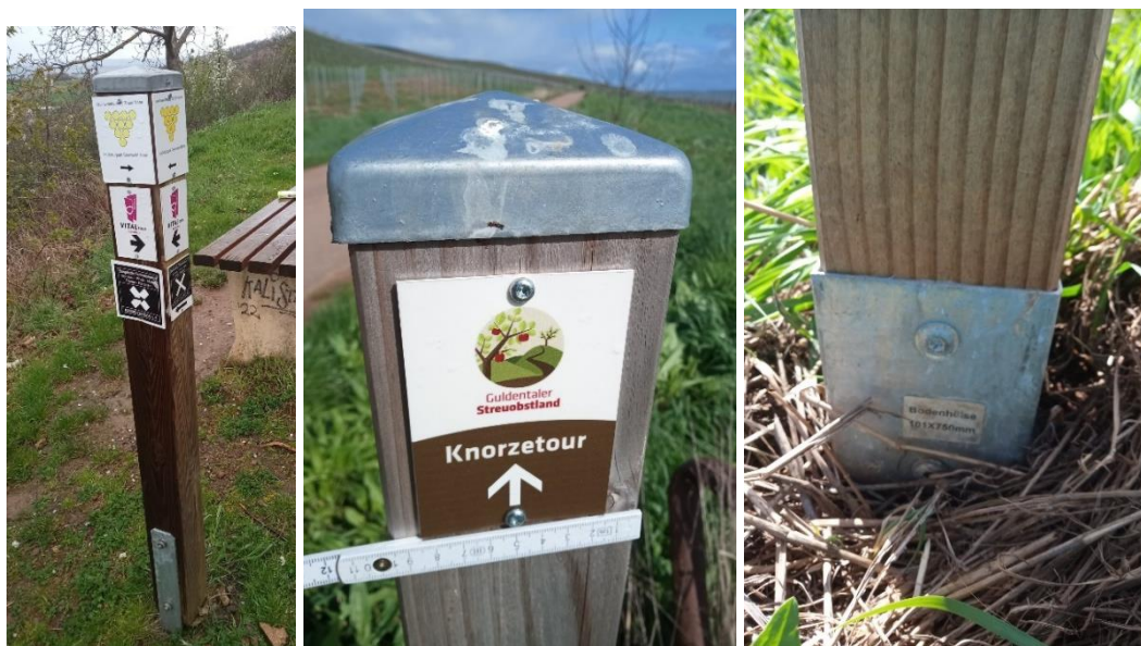
Abb. 42 Beispiel für Markierungspfosten: Vierkantholz 10 x 10 x 100 cm, mit Pfostenkappe u. U-Eisen bzw. Einschlag-Hülse zur Bodenverankerung
