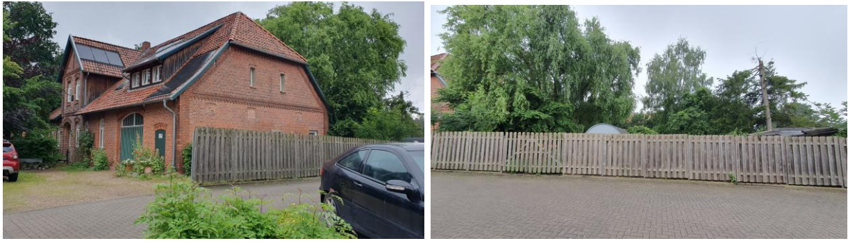
Abb. 15: Baudenkmal Hagener Straße 48 von Osten, links: Gebäude, rechts: Garten (eigene Aufnahmen, Juni 2024)
