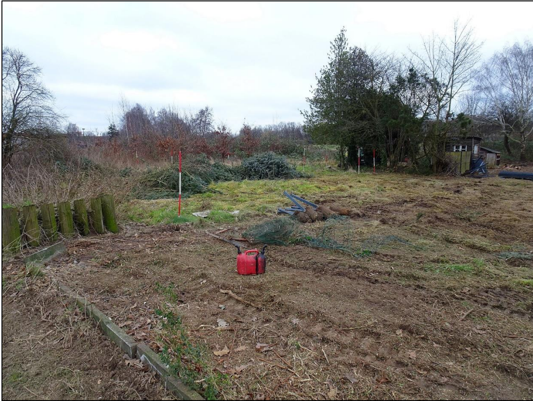
Foto 5: Ehem. Kleingartengelände während des Freiräumens (07.02.2025 / Blick nach NO)
