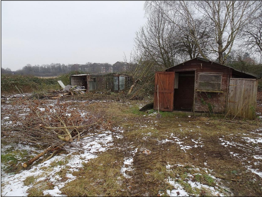
Foto 7: Zwei der drei Gartenhäuschen vor dem Abriss (12.02.2025 / Blick nach O)
