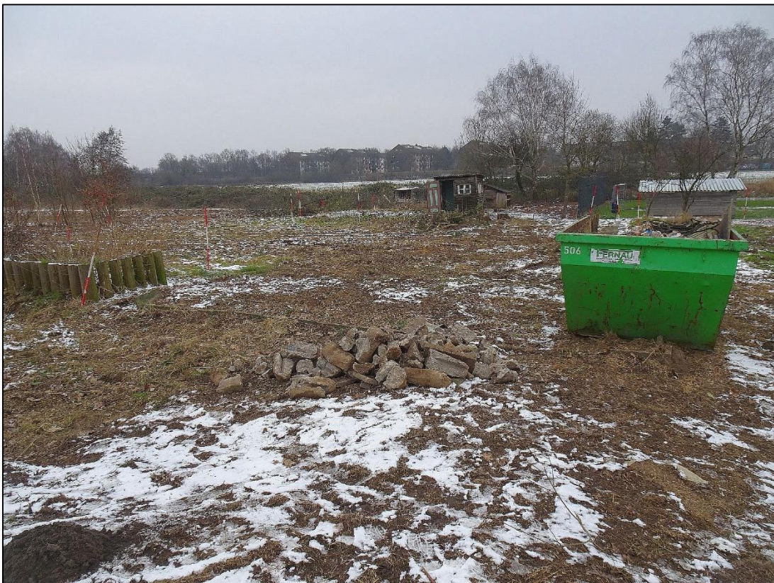
Foto 6: Vergleichsbild zu Foto 5 im fortgeschrittenen Arbeitsstadium (12.02.2025)
