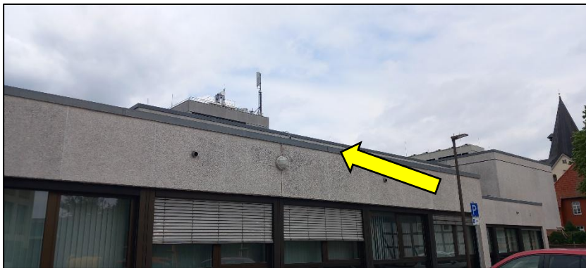
Abbildung 36: Bleche über den Fassadenplatten (gelber Pfeil).
