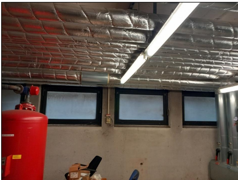
Abbildung 22: Intakte Fenster im Bereich des Heizungskellers.
