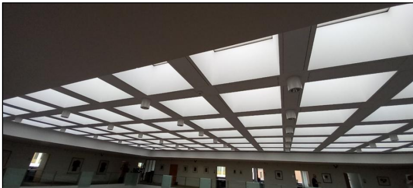
Abbildung 13: Intakte Oberlichter im Foyer.
