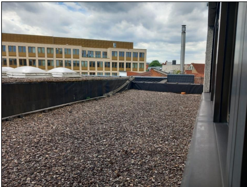
Abbildung 9: Dachfläche zwischen Gebäude Außenfassade und Oberlichtern.
