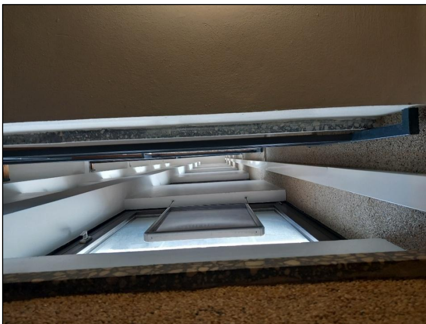
Abbildung 17: Fenster im Treppenhaus.
