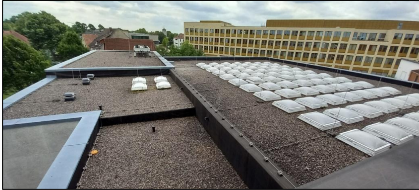
Abbildung 8: Kiesdachbereich mit Oberlichtern.
