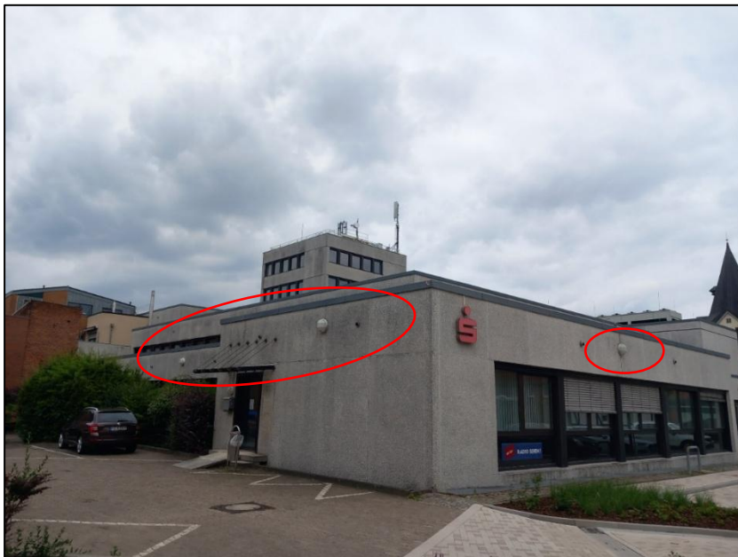
Abbildung 30: Außenbeleuchtung im Parkplatzbereich (Rot).
