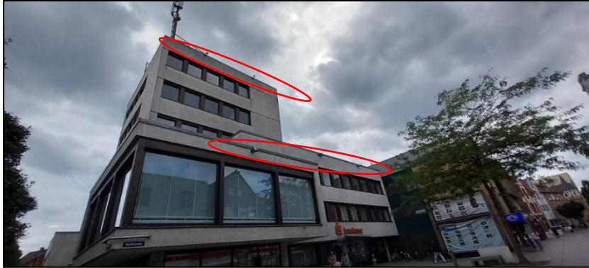
Abbildung 29: Außenbeleuchtung im Bereich des Haupteingangs (Rot).
