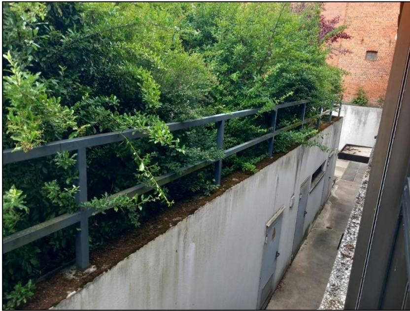
Abbildung 19: Außenzugang zum Kellerbereich.
