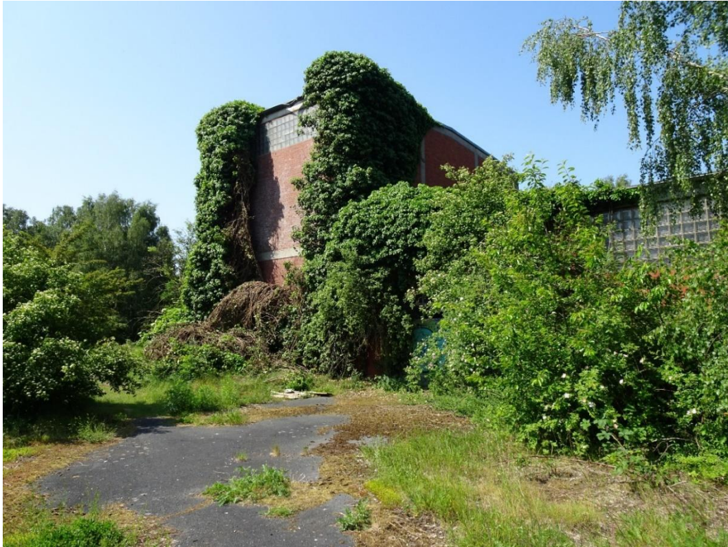
Abb. 28: Alte Industriehalle mit Efeubewuchs, Foto vom 8.6.2025, Blick nach Südwesten (Quelle: agwa 2024)
