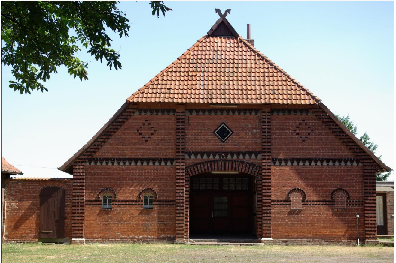
Abbildung 3: Ziegelfassade in Nöpke
