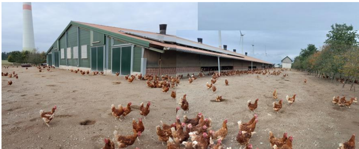
Abb. 3-2: Blick auf die Ostseite des Stallgebäudes
